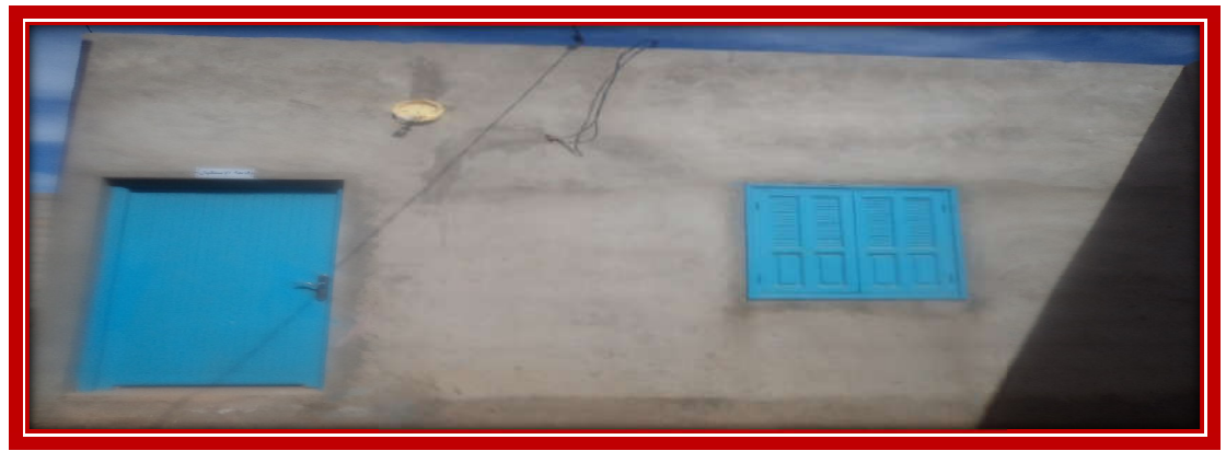
9 - احداث دكان لفائدة المستفيدين
